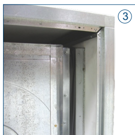
3 Uszczelnienie po stronie wylotu
