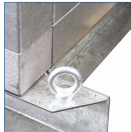
Wszystkie wentylatory wyposażone są w sztywne ramy z uchwytem do podnoszenia, aby ułatwić instalację na podłodze lub suficie.
