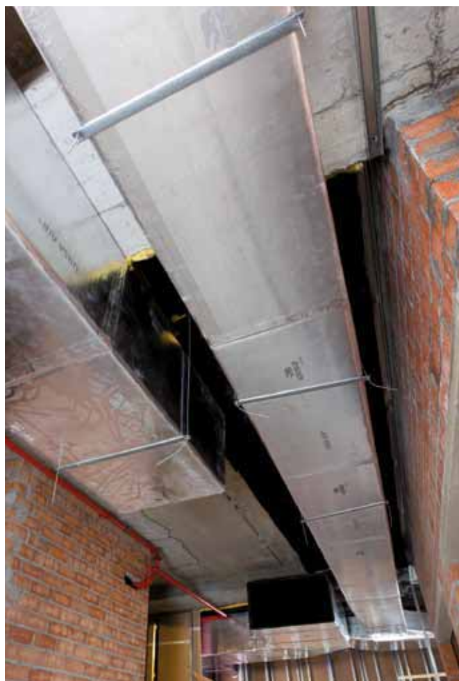
Zdjęcie nr 1 • Powierzchnia zewnętrzna zmontowanej i zainstalowanej sieci przewodów. Na fotografii widoczne są także logo producenta i oznaczenie produktu.
