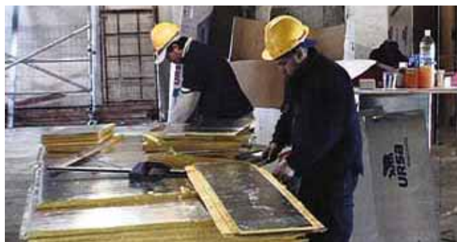
Zdjęcie nr 13 • Stanowisko pracy monterów
