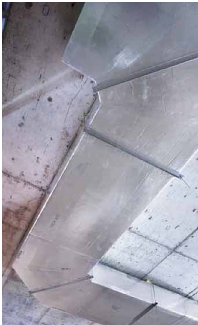
widok zabudowanych otworów rewizyjnych
