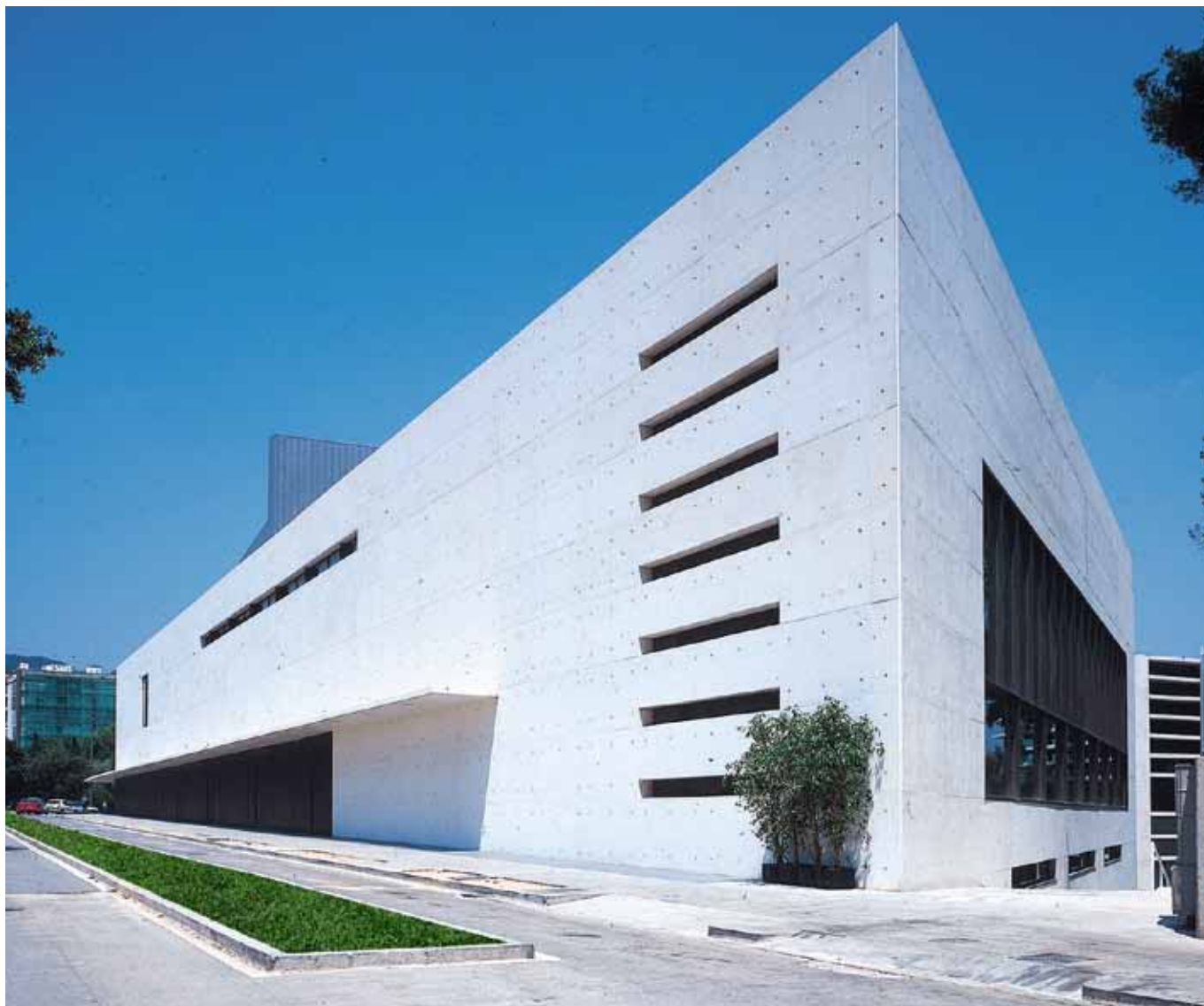
Zdjęcie nr 5 • Palacio de Congressos w Katalonii – instalacja przewodów klimatyzacyjnych z paneli URSA AIR
