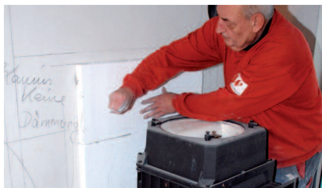
Szybki, dokładny i pewny montaż bardzo trwałej izolacji PROMASIL® 950-KS
