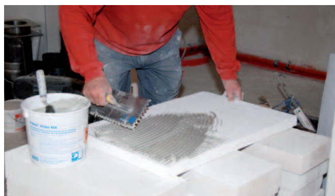
Nakładanie kleju Promat® K84 do PROMASIL® 950-KS
