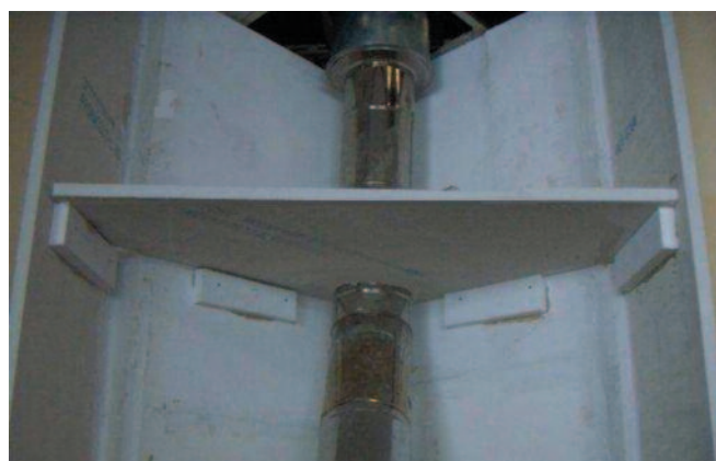
PROMATECT® L – samonośna konstrukcja obudowy kominka
