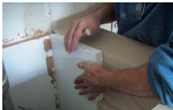
PROMASIL® 950-KS – izolacja ściany
