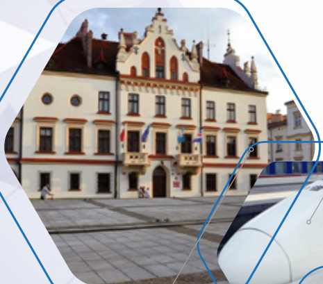
Obiekt Administracji Publicznej w Polsce
